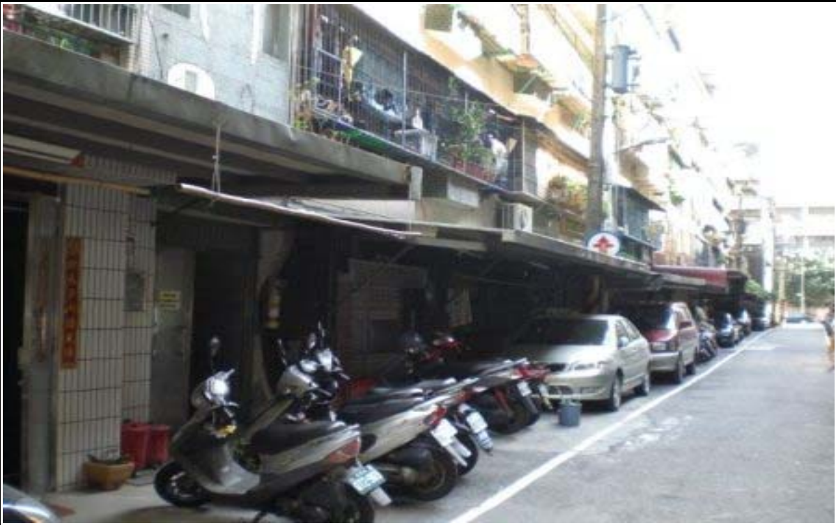
標的臨千歲街61巷50弄現況
